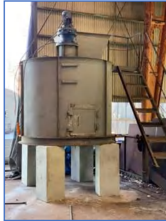
攪拌(かくはん)機の設置が 完了しました！
