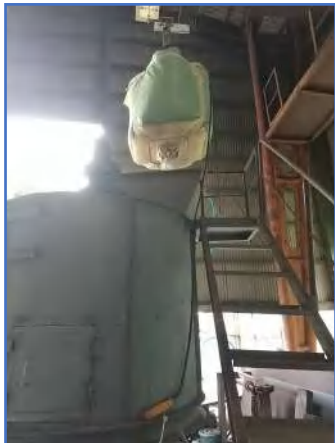
材料はクレーンで引き上げ 上から投入
